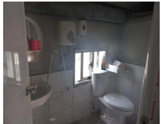
本會協助修繕浴廁
